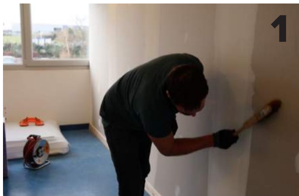
— NETTOYER LA ZONE DE POSE
