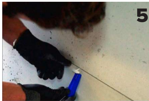
— POSITIONNER LES CALES BLEUES PAR-DESSUS
