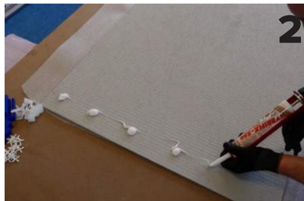
— APPLIQUER LA COLLE SUR LE SLIMBETON®
